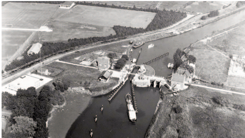
Achter de Waaiersluis bij Gouda begint de Gekanaliseerde Hollandsche IJssel.
