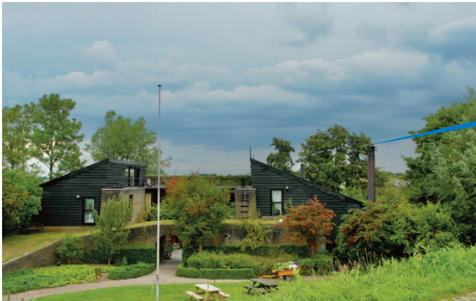
Rijksmonument Steenoven de Olifant. Deze fabriek sloot ±1918. Alleen deze oven in een ensemble van drie werd niet gesloopt en in 1972 verbouwd tot villa.
